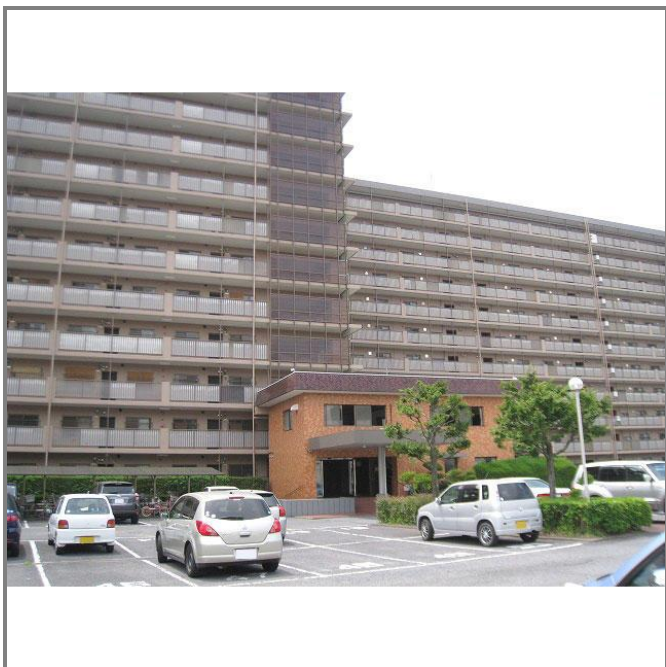
エントランス付近
